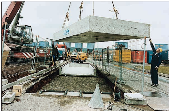
Obr. 24 Montáž prefabrikované vany váhy pro silniční vozidla
